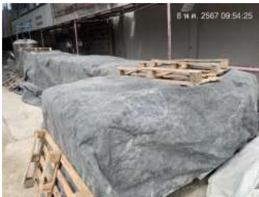
รูปที่ 14 การปิดคลุมกองเก็บวัสดุอุปกรณ์
